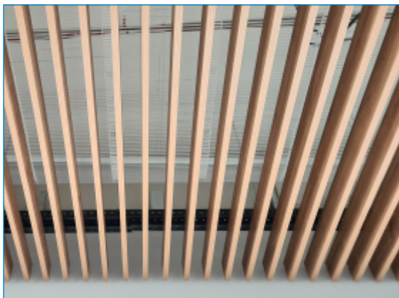
Weiß durchscheinende Kapillarrohrmatten verleihen der Holzlamellenkonstruktion zusätzliche Leichtigkeit.
